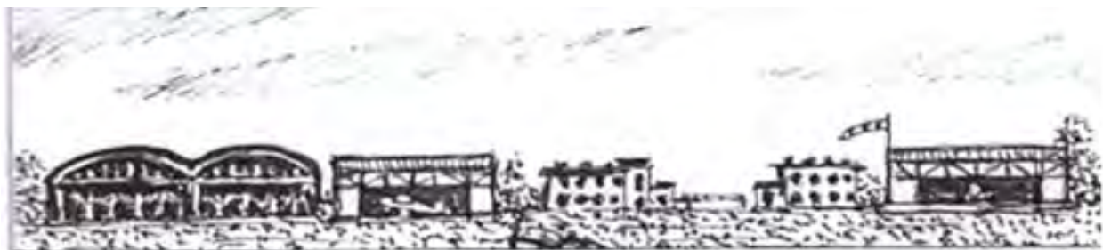
A börgöndi repülőtér dél felől nézve. Jobb oldalon a börgöndi vasútállomás felőli keleti hangár, tőle balra a repülőtér főbejárata (vasúti keresztezés!) és a repülőtéri épületek egy része, középen a nyugati hangár, balra az épülő héjtetős hangár.
