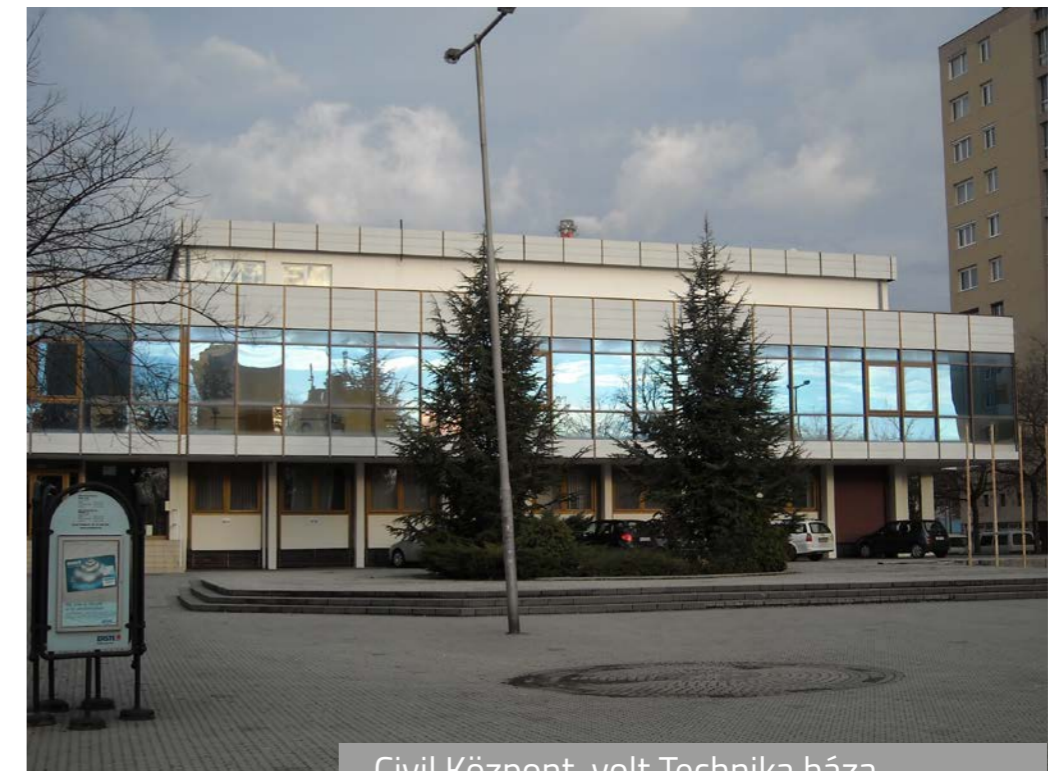
Civil Központ, volt Technika háza
