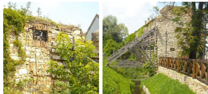
SÖRHÁZ TÉR 1. SÖRHÁZ ÉS SÖRHÁZI MALOM ÉPÜLETEGYÜTTESE védelmi (bírság) kategória: III. (?) törzsszám 9825 (?) hrsz: 4255/5,6,7,8 (?) azonosító: 3892 (?)
